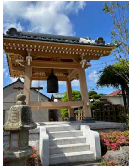
新設された鐘楼
